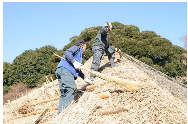
《茅葺屋根葺き替えの様子》
