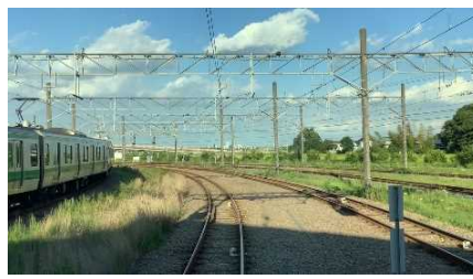
川越車両センター構内
