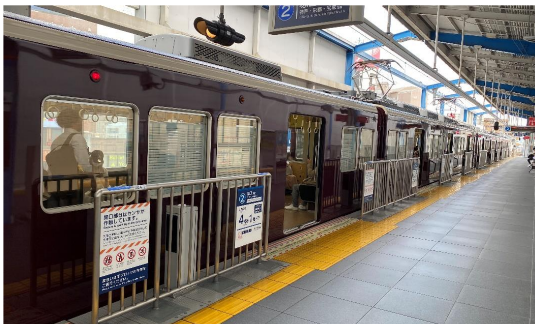
センサ付ホーム固定柵（伊丹駅）
