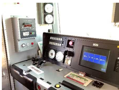
EV-E301系(ACCUM) 運転台
