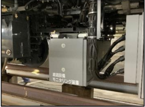
線路設備状態監視 (写真:E131系相模線)
