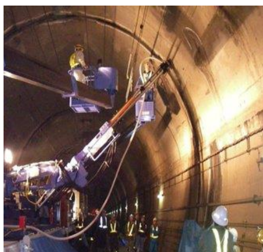
山岳トンネル（ロックボルト打設）
