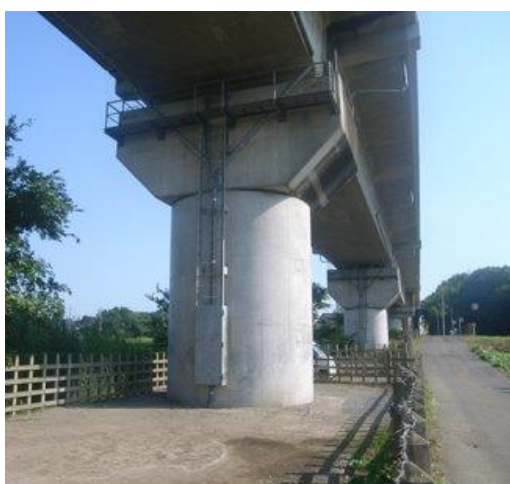
橋脚（鉄筋コンクリート巻立て）
