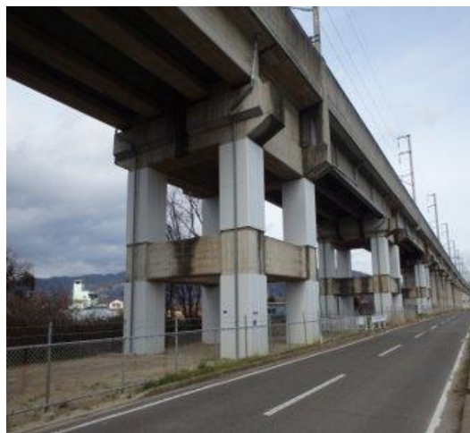
高架橋柱（銅板巻立て）
