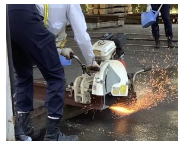
レール切断風景
