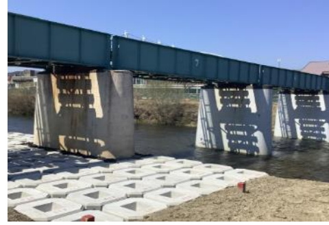
河床の安定性向上（護床工）
