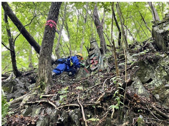
斜面の検査状況
