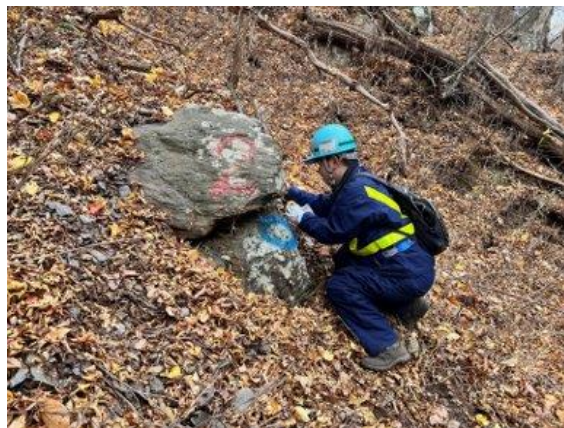
斜面の検査状況
