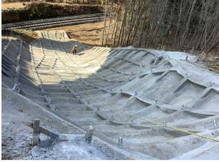
斜面の崩壊防止（のり面工）
