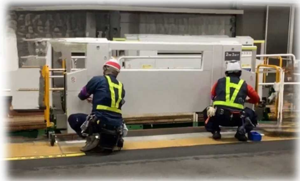
【ホームドア設置作業】
