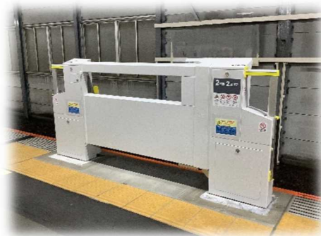
【ホームドア設置】
