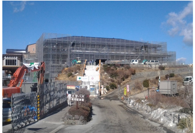
【1月28日現在 工事状況】
