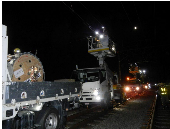
新型トロリ線の張替の様子
