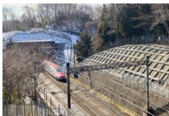
新幹線降雨防災対策
