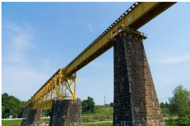
一ノ戸川橋梁(磐越西線)
