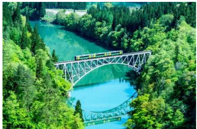
第一只見川橋梁ビュースポット(只見線)
