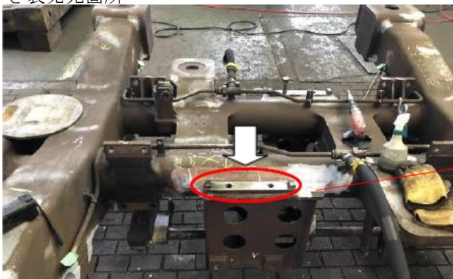
き裂発見箇所
