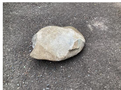
落下していた石
