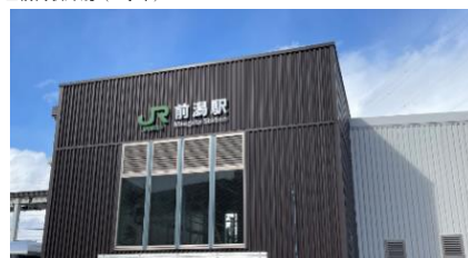
■前潟駅外観（工事中）
