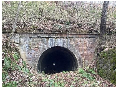
旧宮守トンネル
