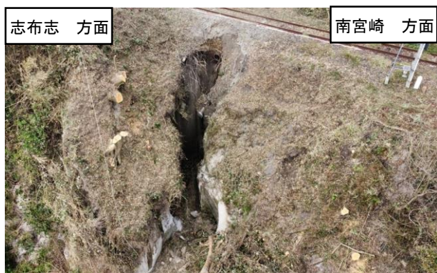
日南線 大隅夏井駅～志布志駅間 築堤崩壊現場 (左：被災後(2022年9月26日撮影)、右：現在(2023年2月18日撮影))
